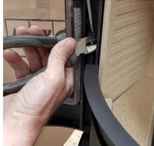
Den Stift entfernen und die Schraube anziehen (Uhrzeigersinn) je nach dem wie schnell die Tür zugehen soll.
