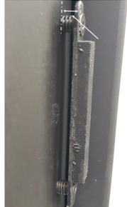
For å endre trekk i døren, justeres de to magnetmoduler.
